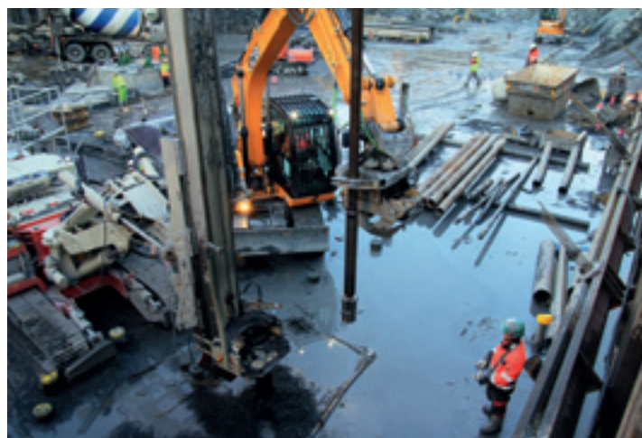
Med klype og klo på tiltrotatoren er JCB-graverne en god støtte-spiller på anleggstomta.
